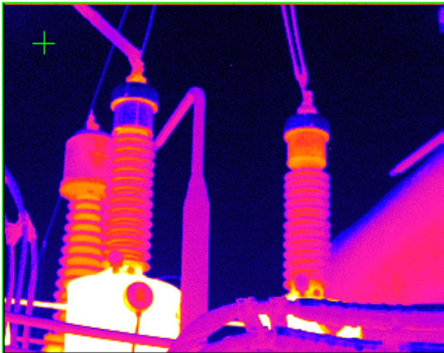
Рис. 1. На переднем плане вводы фаз **В** и **А** 110 кВ АТ 220/110 кВ
