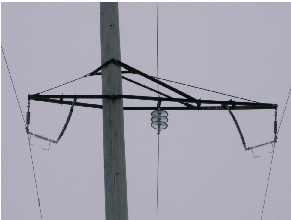
Рис. 17. Промышленная ВЛ 35 кВ в «Камышинских электрических сетях» ОАО «Волгоградэнерго» с РМК, установленными на крайних фазах и ИРМК- на средней фазе.
